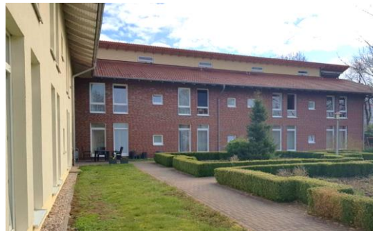
Sonnenhaus Ramsloh – Ramsloh
