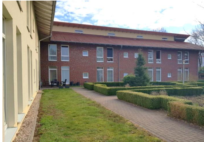
Sonnenhaus Ramsloh – Ramsloh
