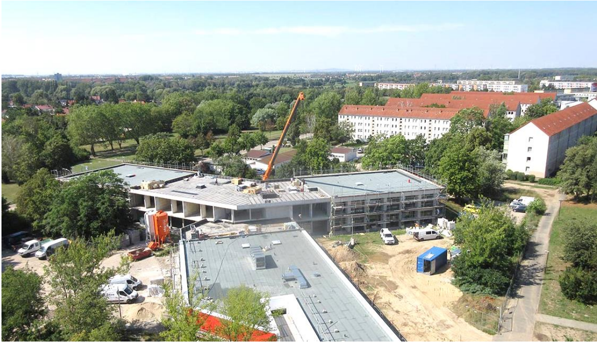
SARA Seniorenresidenz Haus III (aktuelle Baustelle) – Bitterfeld-Wolfen
