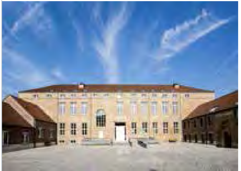
RESIDENCE BLARET BELGIQUE – LOGEMENT DES SENIORS
